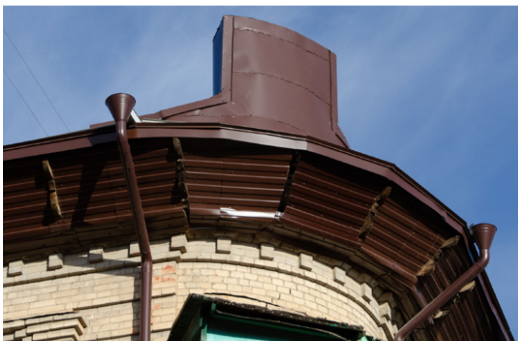
Аттик и карниз, полностью зашитые металлом
