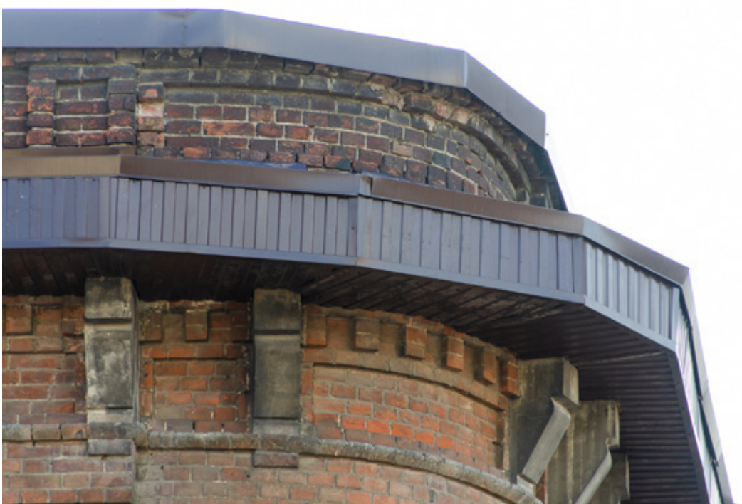
Карнизы сбивают, упрощают, обшивают металлом
