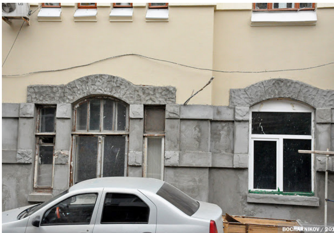
Оригинальные окна — декоративный элемент фасада. Сравните, как проигрывает внешний вид здания после установки обычных металлопластиковых стеклопакетов
