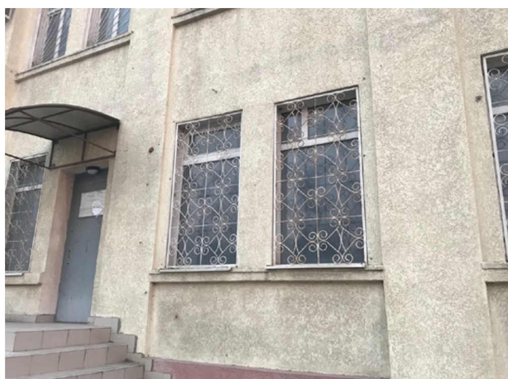
Фрагмент фасада вблизи — штукатурка «короед»
