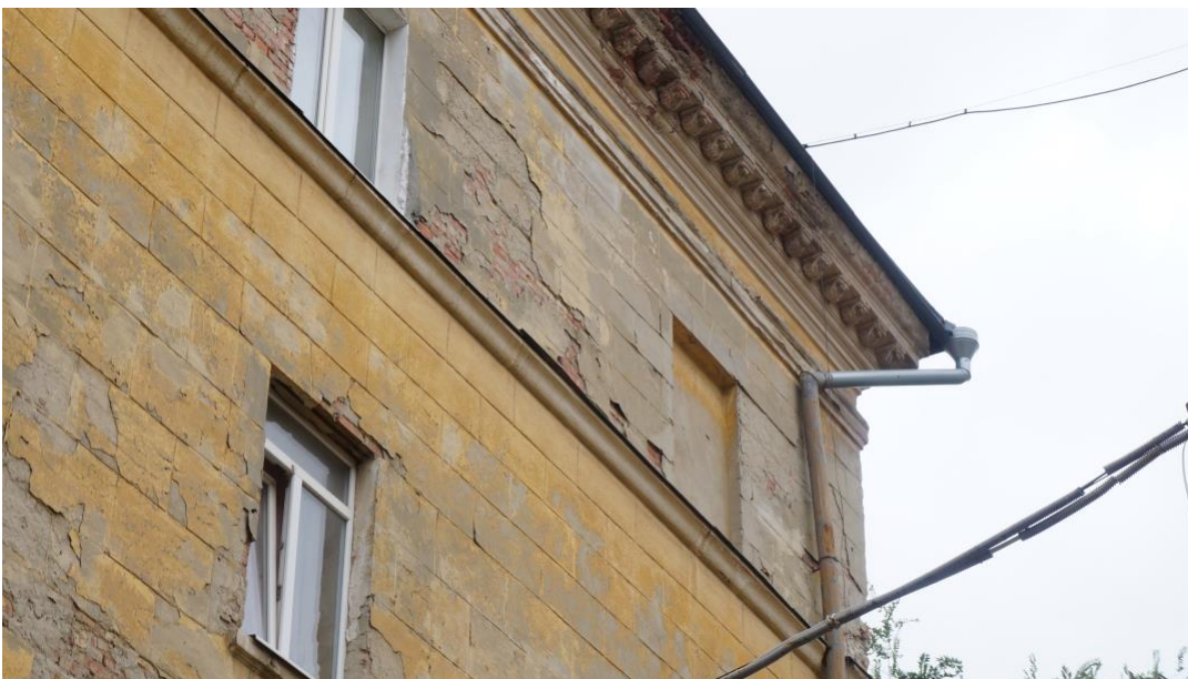
По фото видно, что здание было оштукатурено, можно рассмотреть состояние штукатурного слоя
