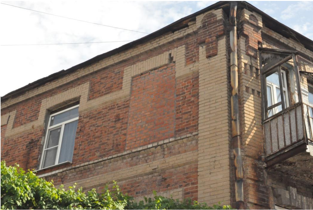
Дореволюционный кирпичный, неокрашенный фасад, сложенный из двух видов кирпича
