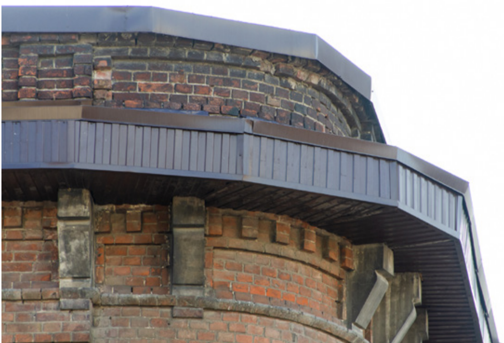
Карнизы сбивают, упрощают, обшивают металлом
