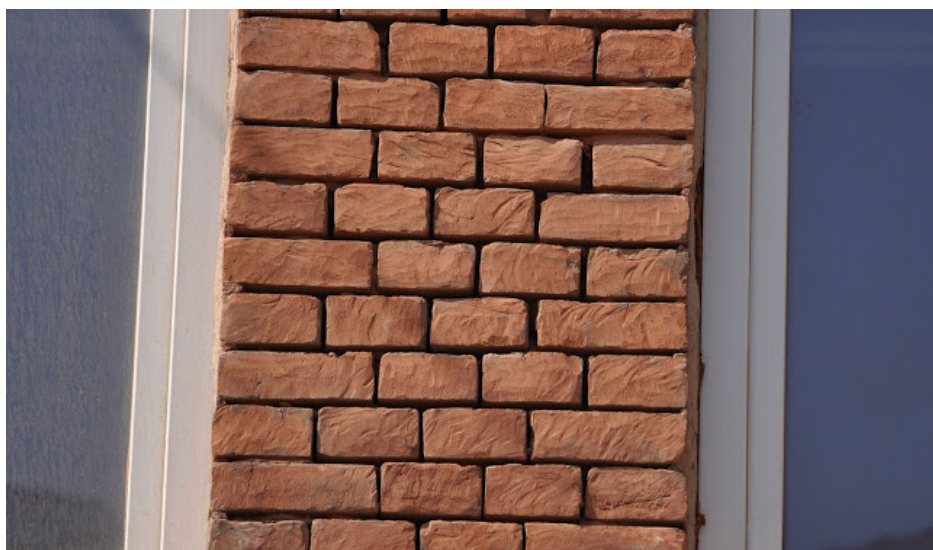
На кирпиче не должно быть механических следов расчистки, такие следы похожи на насечки
