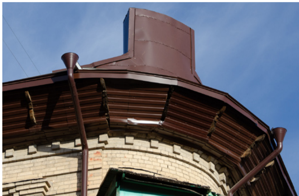
Аттик и карниз, полностью зашитые металлом
