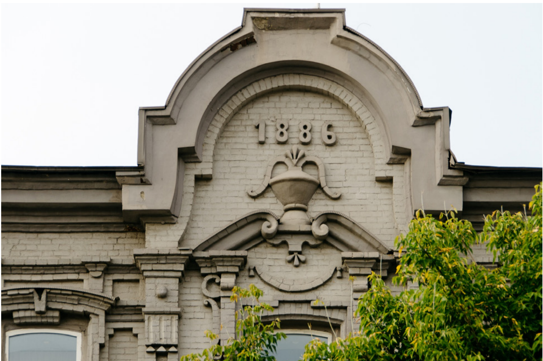
Аттик исторического здания
