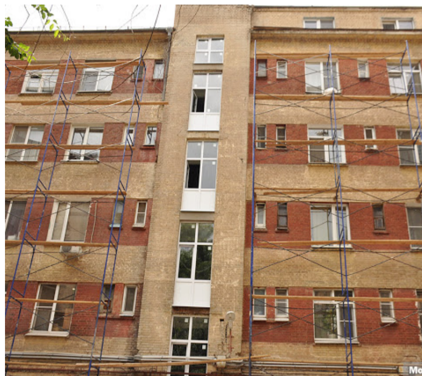
После ремонта изначальную расстекловку деревянных рам часто заменяют на несуразные пластиковые окна
