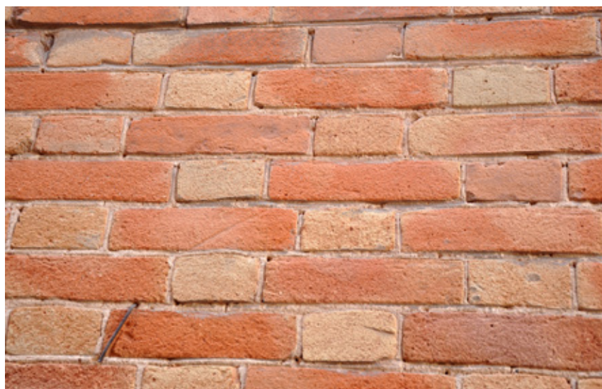
Поверхность кирпичной кладки после правильно выполненной очистки— ровная, без повреждений
