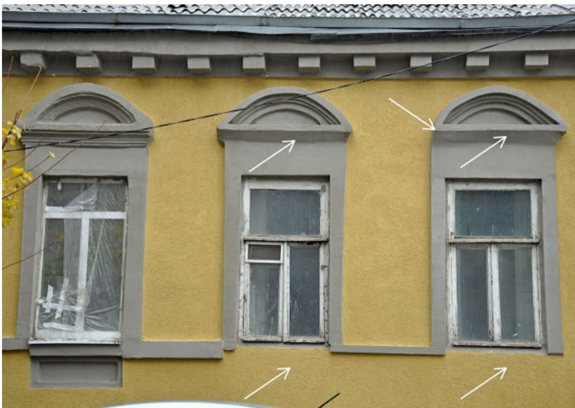
Пример ремонта исторического здания без охранного статуса - декоративные элементы над окнами выведены грубо, под окнами после ремонта остались ничем не восполненные утраты.
